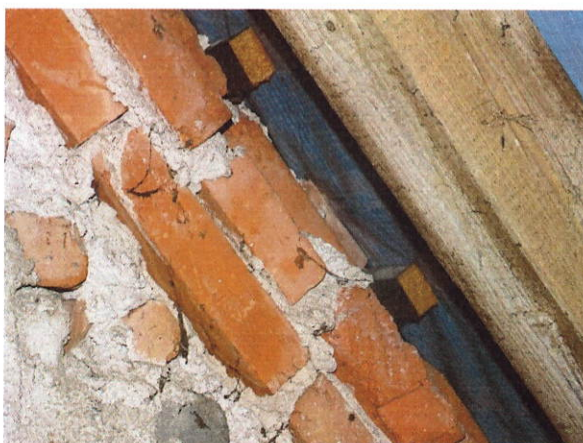
č. 28 – 29 Detaily konstrukce krovu a spojení štítové stěny se střešní konstrukcí, podstřeší budovy A
