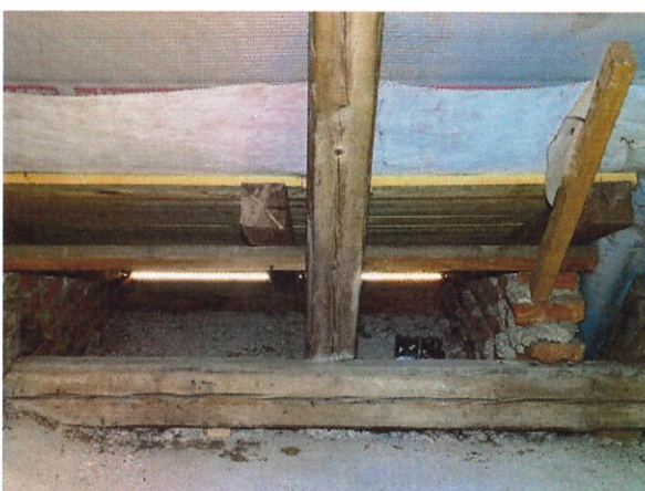
č. 28 – 29 Detaily konstrukce krovu a spojení štítové stěny se střešní konstrukcí, podstřeší budovy A
