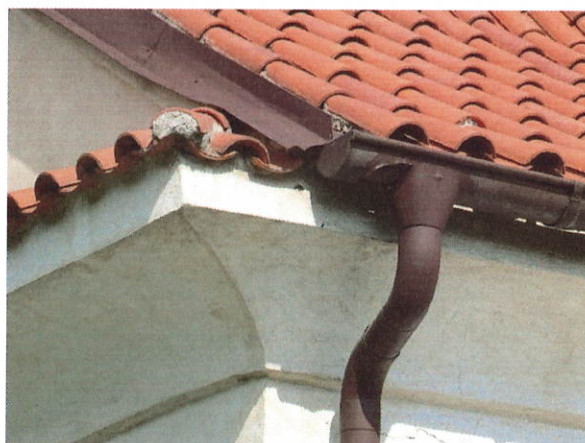
č. 41 – 44 střešního pláště a spojení střešní konstrukce s obvodovým zdívem, budova C
